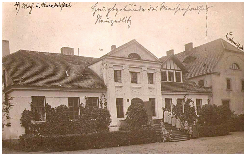
Ilustr. 1. Budynek główny sierocińca w Ruchocinie (zbiory prywatne)
