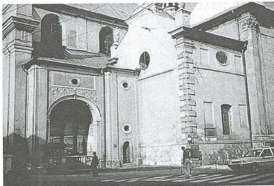
Elewacja kościoła od południa
