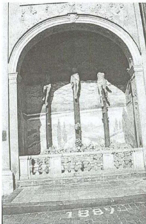
Pasja na elewacji kościoła od południa
