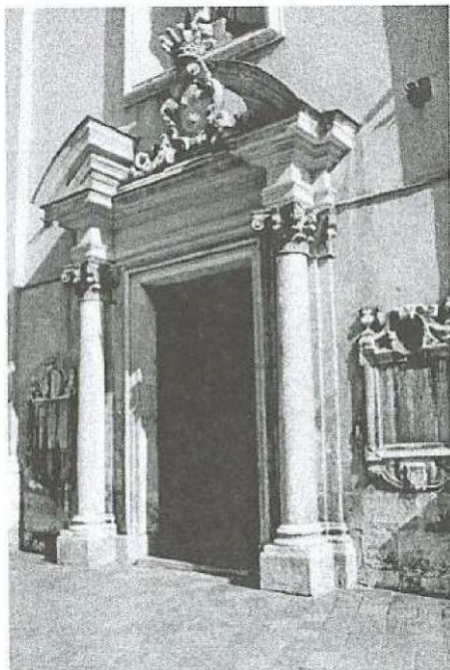
Portal główny kościoła
