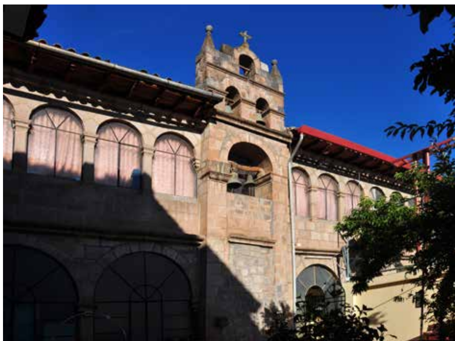
Fig. 2. Arcos y espadaña, elementos originales en el antiguo Beaterio del Carmen. Último tercio del siglo XVIII, con las reconstrucciones realizadas tras el terremoto del 1950, fot. Ewa Kubiak, 2018.
