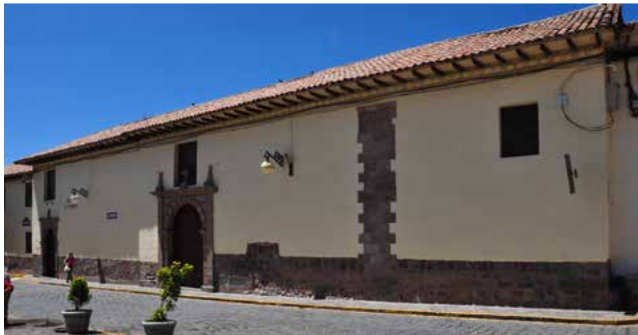
Fig. 1. El antiguo Beaterio del Carmen, vista de la Plaza de San Blas. Último tercio del siglo XVIII, con las reconstrucciones realizadas tras el terremoto del 1950, fot. Ewa Kubiak, 2018.
