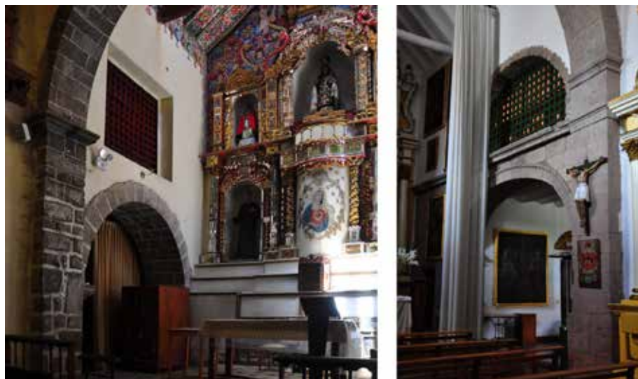
Fig. 7. El presbiterio con el elevado coro de la capilla del antiguo Beaterio del Carmen. Último tercio del siglo XVIII con las reconstrucciones realizadas tras el terremoto del 1950. El presbiterio con el elevado coro de la capilla del antiguo Beaterio de las Nazarenas. Siglo XVIII, fot. Ewa Kubiak, 2018.
