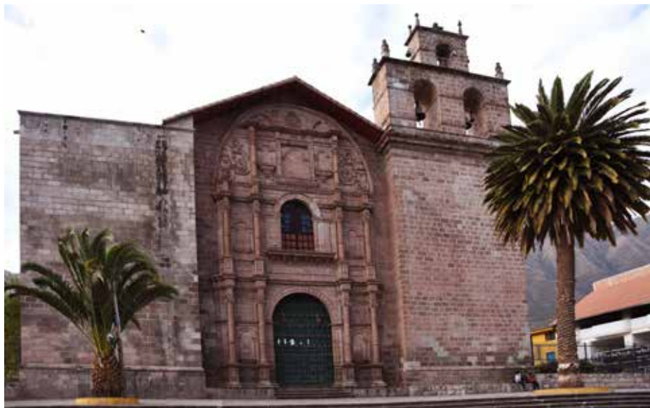
Fig. 1. Fachada de la iglesia parroquial de San Pedro, Urubamba, Perú (fot. E. Kubiak, 2020).
