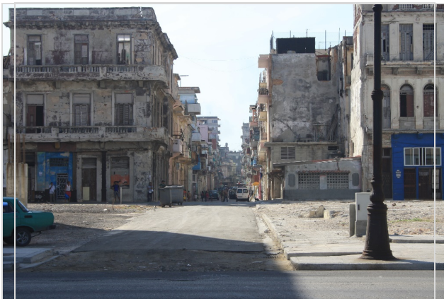
Fot. 3 i 4. Przykłady degradacji substancji mieszkaniowej w Hawanie
