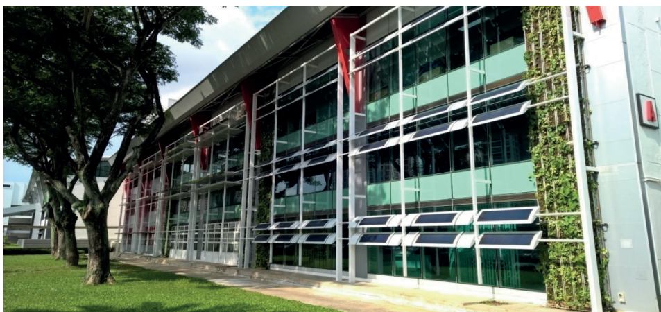
Zdjęcie 3. Zero Energy Building agencji Building and Construction Authority
