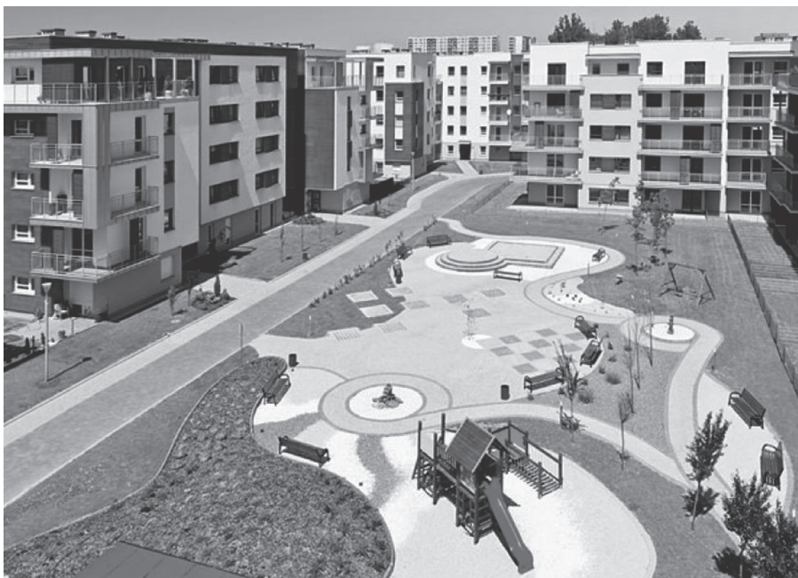
Ryc. 3. Przykład realizacji terenów rekreacyjnych osiedla Nowe Polesie, Łódź Źródło: www.nowepolesie.pl .
