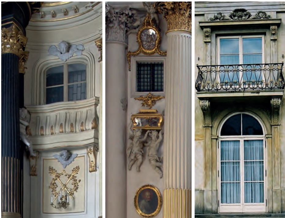
12. Od lewej: a) Łowicz, kolegiata Wniebowzięcia NMP, kaplica Komorowskiego – detal, fot. autorka, 2019; b) Warszawa, kościół Wazytek, ściana szczytowa prezbiterium – detal, fot. autor, 2019; c) Warszawa, pałac Na Wyspie, elewacja południowa – detal, fot. autor, 2017
