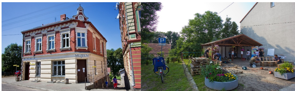
Ryc. 13. Zabytkowa kamienica pod adresem pl. Wolności 4. Siedziba Muzeum Regionalnego oraz Cedynskiego Ośrodka Kultury i Sportu. Po lewej stronie budynku widać parking, a z prawej – ul. Krótką, prowadzącą do alei kasztanowej. Na miejscu parkingu mieszkańcy Cedyni stworzyli kawiarenkę sąsiedzką (stan: 2017 r.)
