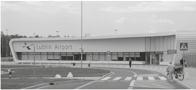
Fotografia 3. Terminal w Lublinie Źródło: fotografia własna
