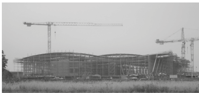
Fotografia 1. Budowa nowego terminalu we Wrocławiu Źródło: fotografia własna
