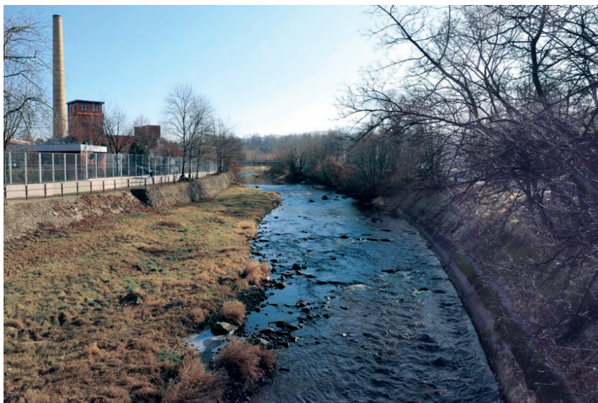
Ryc. 1. Modernizacja infrastruktury rzeki Białej Głuchołaskiej w Głuchołazach Fot. PGW Wody Polskie
