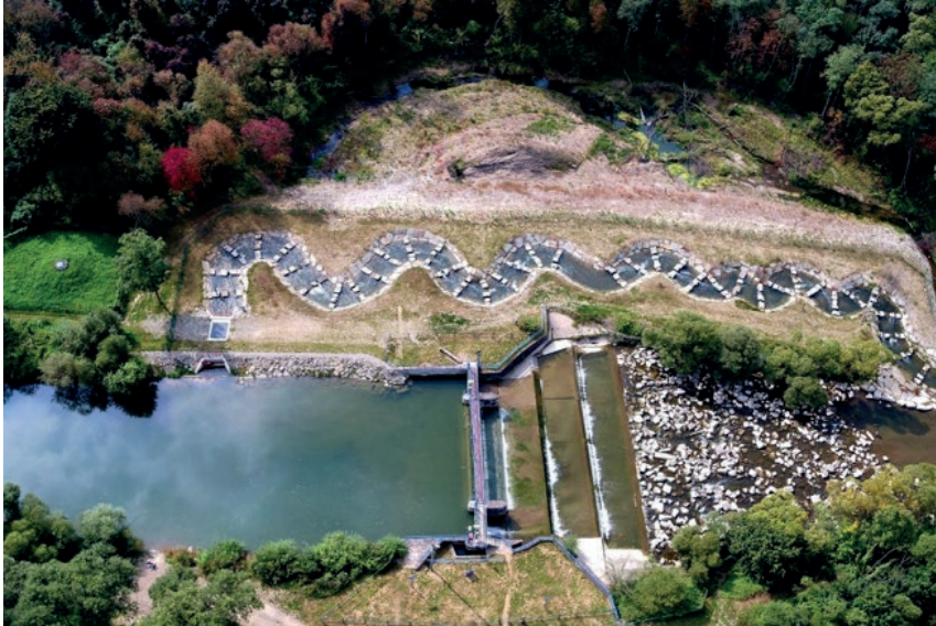
Ryc. 3. Modernizacja przepławek na Jasiótkce, stopień wodny, Brzeg Dolny Fot. PGW Wody Polskie
