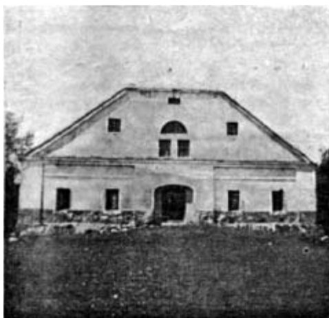
Il. 9. Spichlerz z 1934 r. sprzed przebudowy na kaplicę, fotografia w „Królowej Apostołów”, 1936, nr 9, s. 271, Archiwum Polskiej Prowincji Sióstr Pallotynek.
