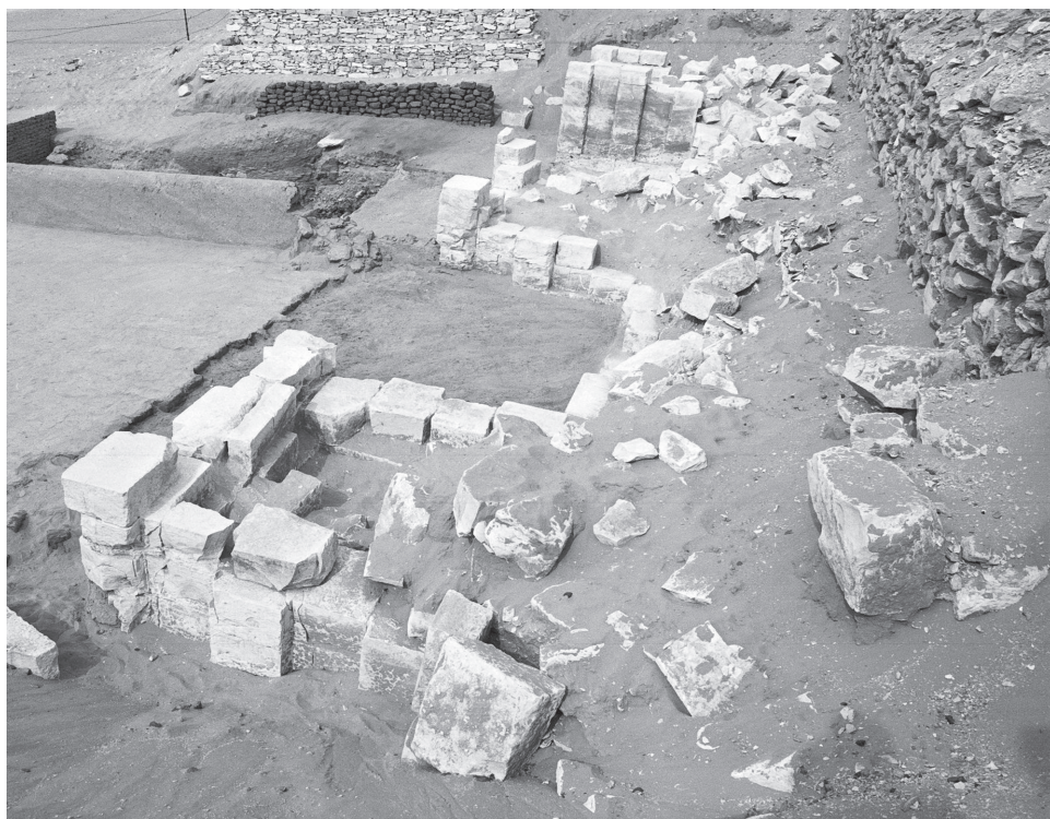
Il. 6. Fragment zachodniej części muru kompleksu Piramidy Schodkowej; pośrodku widoczne są pozostałości wapiennej licówki, po prawej stronie – wewnętrzna struktura z bloków taflu (fot. M. Jawornicki/CAS UW)
