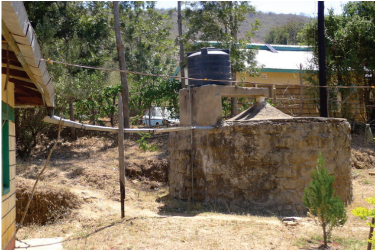
Ryc. 12. Zbieranie deszczówki z dachu do zbiornika, fot. M. Szupejko
