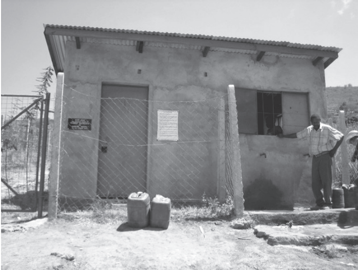
Ryc. 7. Ostatni etap sprowadzenia wody: ze śluzy do zbiornika z kranem, fot. M. Szupejko
