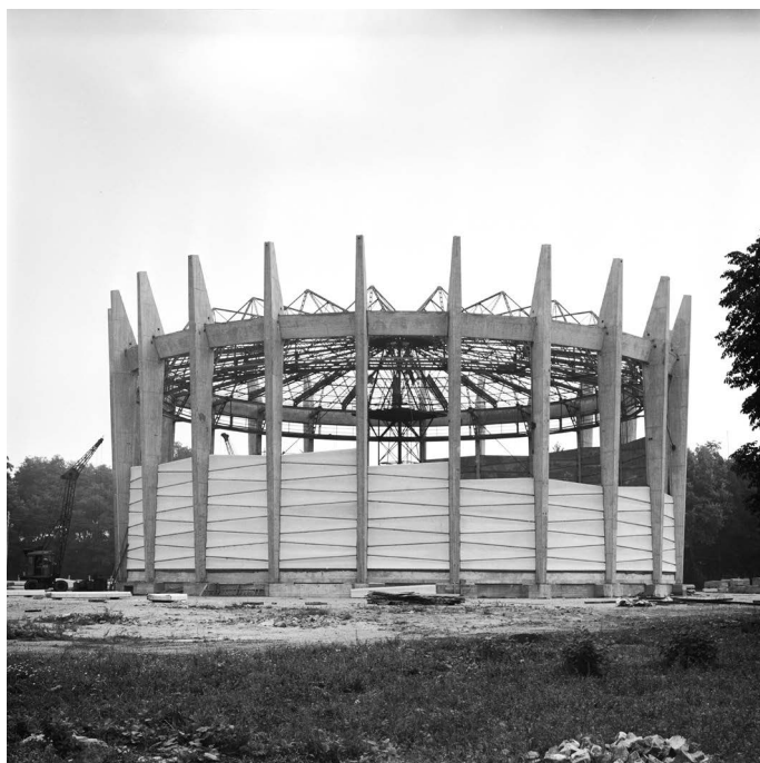
Il. 4. Budowa rotundy i montaż płyt ściennych, 1967 r., fot. Andrzej Osiński (źródło: Muzeum Architektury we Wrocławiu)
