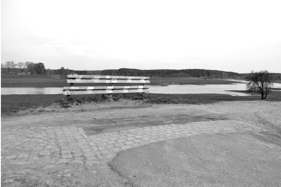
Ryc. 7. Pozostałości lewobrzeżnego przyczółku nieistniejącego mostu w Krobielewku, 2021, fot. G. Urbanek
