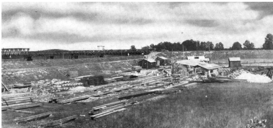
Ryc. 1. Skład materiałów do budowy mostu w Krobielewku – lewy brzeg Warty, źródło: Pommerrenig, Holzbrücke , s. 162.
