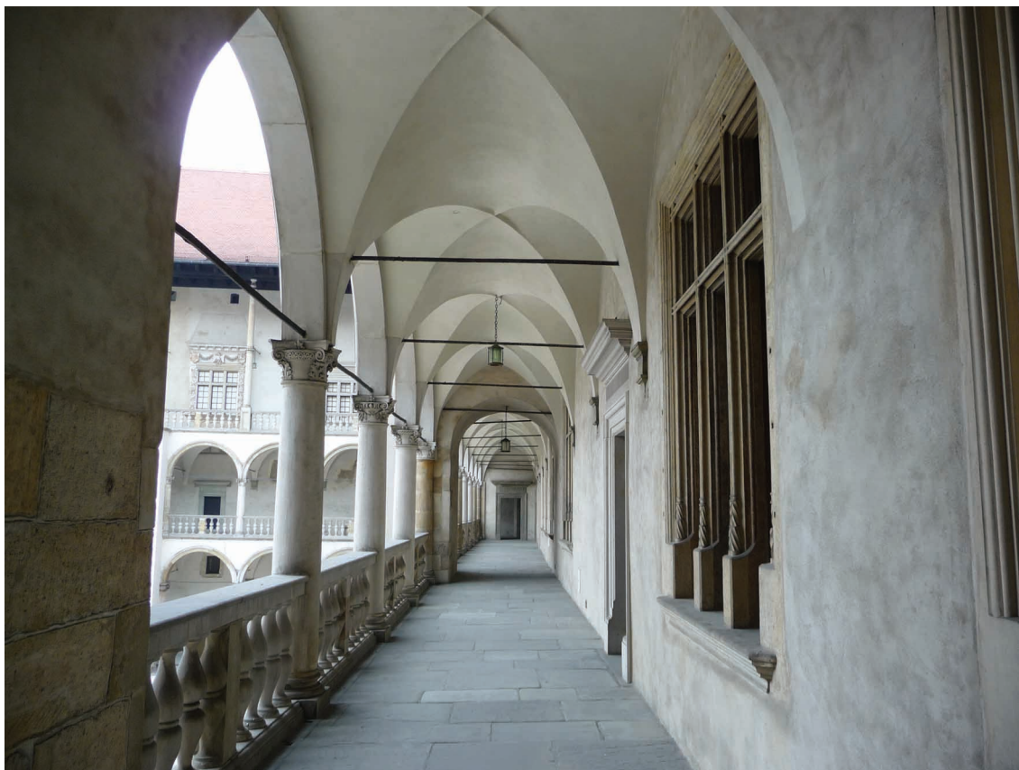
4. Krużganek pierwszego piętra skrzydła północnego – w głębi widoczne sklepienie przęsła przy filarze przed salą jadalną króla. Fot. S. Mossakowski
