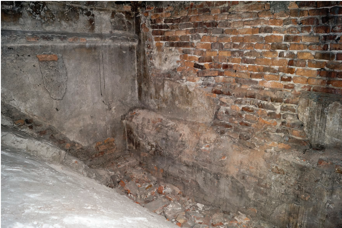
3. Relikty wolut i szczytu wschodniego attyki nad obecnym kościołem. Fot. Maria Pokorna
