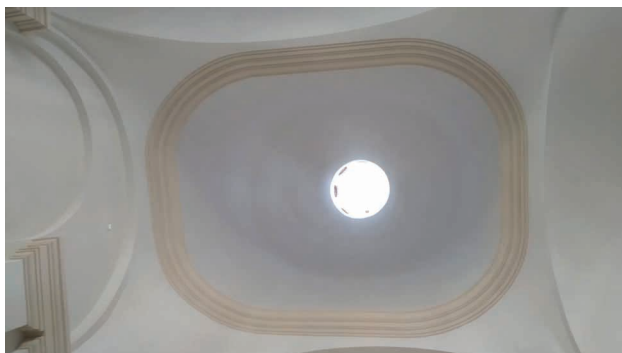
18. Kościół franciszkanów w Zamościu, wewnątrz kopuły kaplicy południowej, stan w 2021 r.
