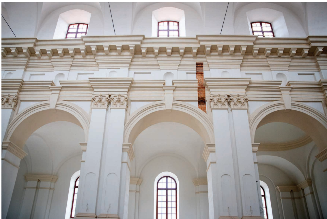
15. Kościół franciszkanów w Zamościu, widok na belkowanie nawy głównej, stan w 2021 r. Fot. Aleksander Stankiewicz
