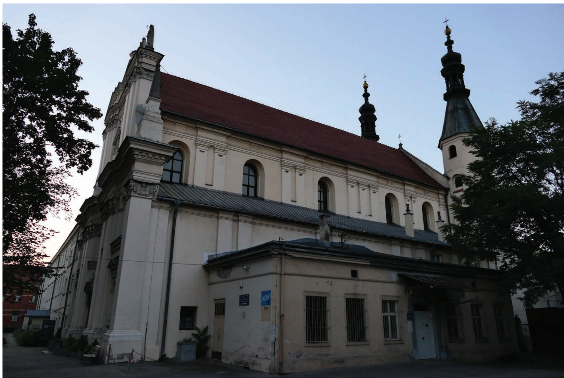
29. Kościół Niepokalanego Poczęcia NMP w Krakowie, elewacja od strony zachodniej. Fot. Aleksander Stankiewicz
