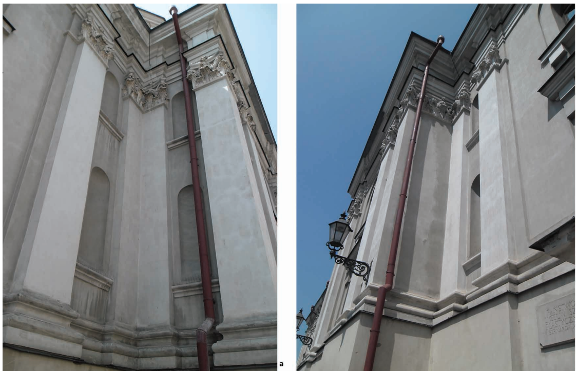
21a-b. Kościół franciszkanów w Zamościu, fragmenty elewacji naw bocznych i kaplic: a) od strony północnej; b) od strony południowej, stan w 2010 r. Fot. Aleksander Stankiewicz
