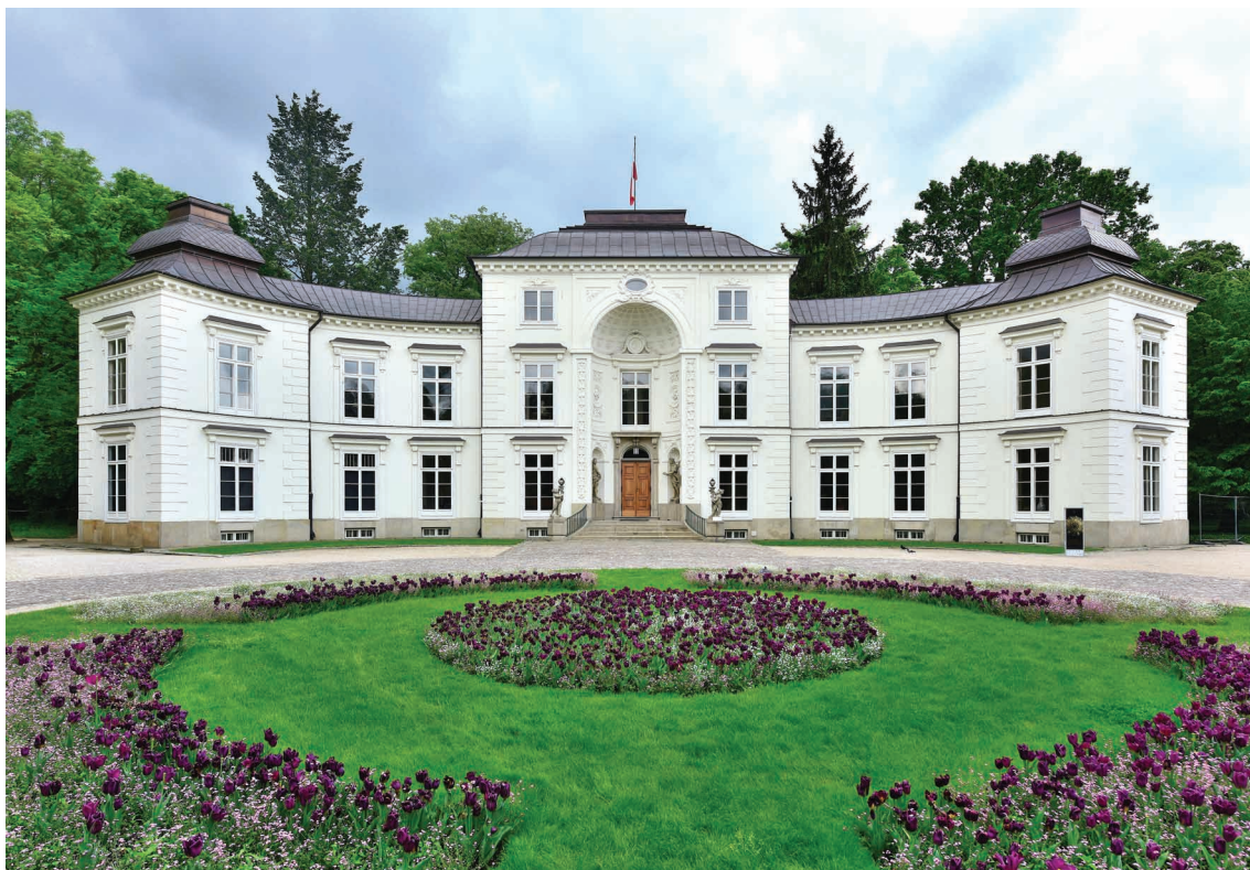
26. Pałac Myślewicki w Łazienkach Królewskich w Warszawie – widok fasady. Fot. Adrian Gryczuk
