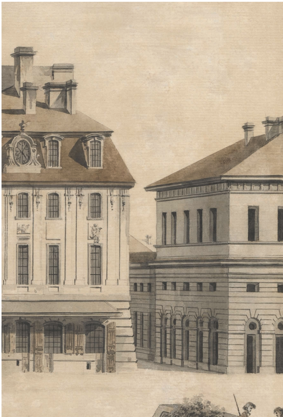
23. Kamienica Izabeli Branickiej u zbiegu ulic Senatorskiej i Podwale w Warszawie. Fragment akwareli Zygmunta Vogla Widok Krakowskiego Przedmieścia od placu Zamkowego z około 1785 roku. W zbiorach Muzeum Narodowego w Warszawie. Fot. MNW
