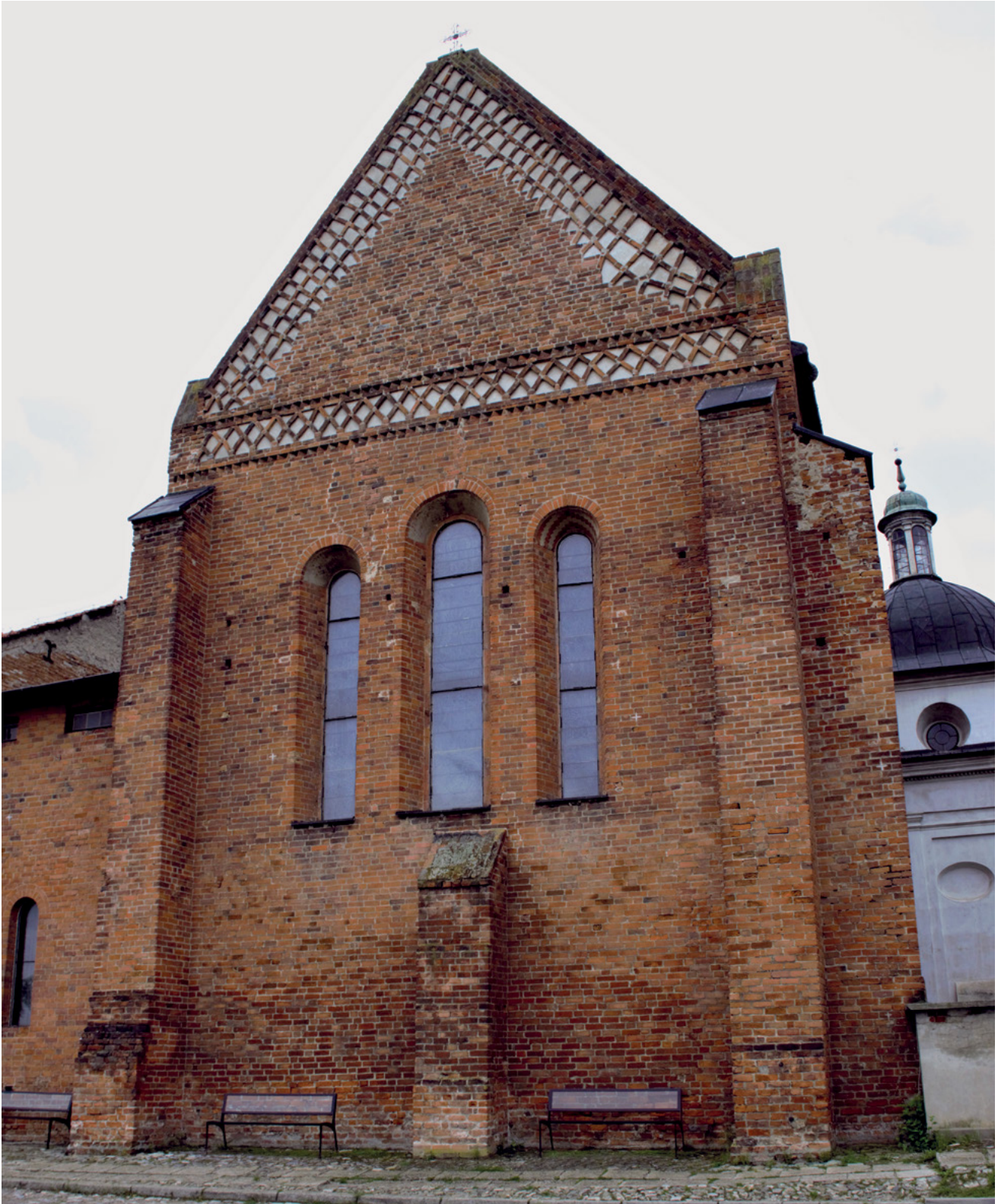
2 Prezbiterium kościoła Dominikanów w Sandomierzu, widok na narożnik południowo-wschodni. Fot. Justyna Kamińska
