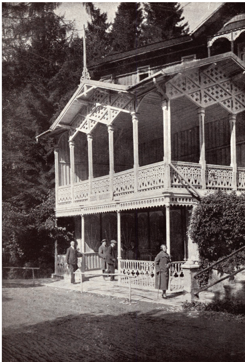
35. Szczawnica, estrada nad źródłem „Walerii”.
