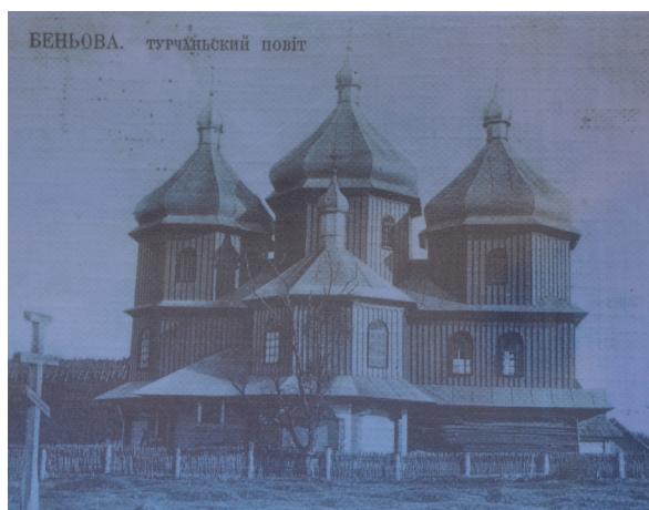
Il. 18. Cerkiew pw. św. Michała Archanioła z 1909 roku na pocztówce z lat 30. XX wieku, fot. ze zbiorów P. Kusala ( Zapomniane cerkwie , wyd. Ruthenus), fotografia cerkwi na tablicy informacyjnej w Bukowcu, październik 2021, fot. K. Zielińska.
