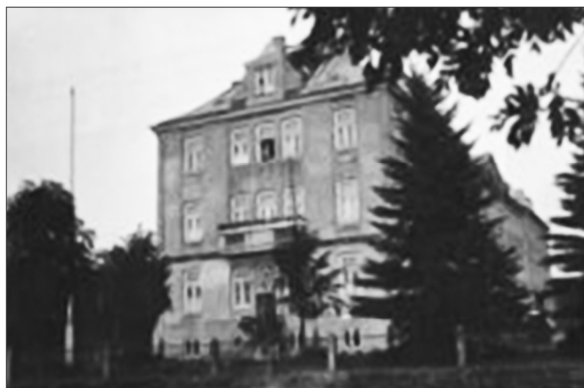
Elewacja szpitala od strony zachodniej
