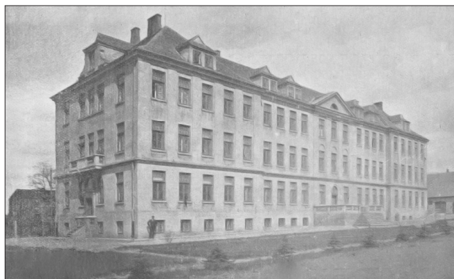
Budynek Szpitala powiatowego pw. św. Antoniego (strona pld. zach.)
