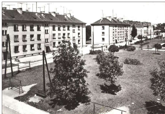
Fot. 14. Budynek mieszkalny przy ul. Narutowicza 85A, B i C zbudowane w latach 1951–1953. Widok od strony wschodniej z lat 70. ubiegłego wieku. Zdjęcie ze zbiorów archiwalnych MG Biblioteki Publicznej w Żychlinie
