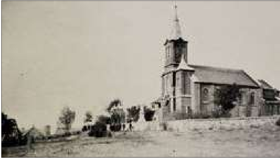
Kurowo, kościół parafialny, widok od południowego zachodu Fot. Archiwum Diecezjalne w Płocku, sprzed 1927 r.
