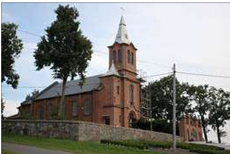
Kurowo, kościół parafialny, widok od północnego zachodu. Fot. A. Warczachowska, 2021 r.
