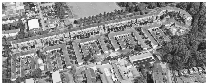
Fot. 3. i 4. IBA Emscherpark 1999. Przykłady budownictwa socjalnego nawiązujące do tradycji przyfabrycznych osiedli robotniczych i patronackich (fot. 3 – górne) Gelsenkirchen Siedlung Schüngelberg
