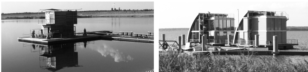
Fot. 5. i 6. IBA SEE Fürst Pückler Land 2010. Pływające domy jako innowacja urbanistyczna mająca zaktywizować brzegi jezior – proces osiadania gruntu nie gwarantuje stabilności posadowienia budynków
