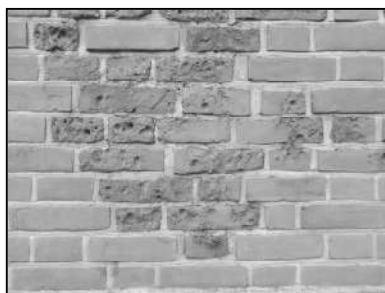
Ryc. 4. Przykład wymiany cegieł na kościele Ścięcia św. Jana Chrzciciela w Chojnicach
