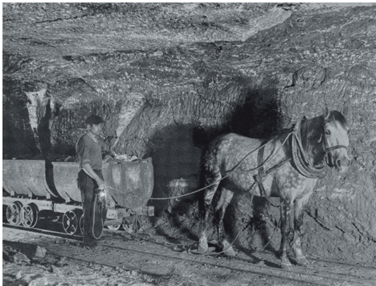
Fot. 8. Konny transport soli na poziomie VIII kopalni bocheńskiej, lata 50. XX w.
