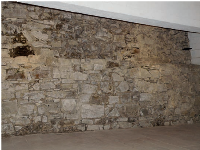
Fot. 9. Lico kamienne w posadowieniu muru po stronie południowej szybu (skansen górniczy)
