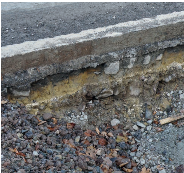
Fot. 16. Kolejne, historyczne już nawierzchnie dróg. Od góry: asfalt, kostka porfirowa z połowy XX w., szuter wapienny, bruk z łamanego piaskowca z okolic Wieliczki i tzw. kamień „rabski” (XIX w.)
