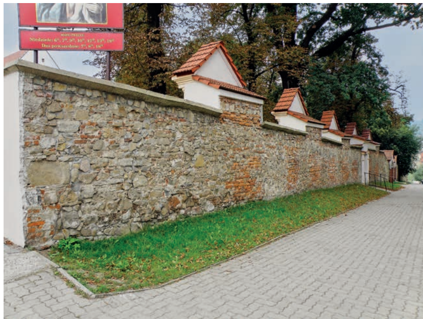
Fot. 15. Mur klasztoru oo. Reformatów od strony zachodniej
