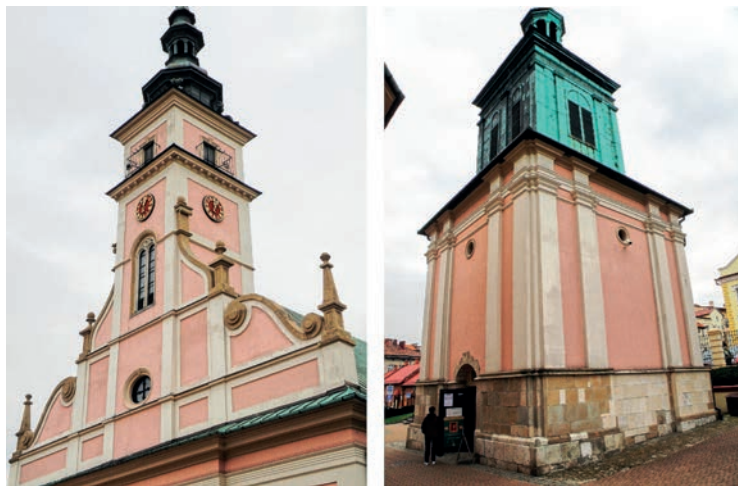
Fot. 14. Detale kamieniarskie w fasadzie kościoła św. Klemensa oraz cokół dzwonnicy
