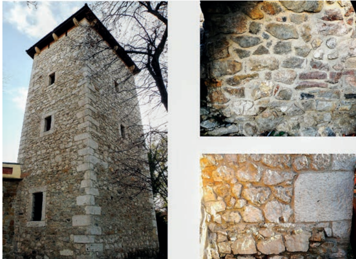
Fot. 11. Baszta obronna. Po prawej dwa lica murów baszty: u góry łamane bloki jurajskiego wapienia skalistego z ciosanym blokiem wapienia gruboławicowego (węgiel) oraz z uzupełnieniami piaskowcem szydlowieckim; poniżej konstrukcja z łamanego piaskowca lokalnego (Biskupice i okolice)
