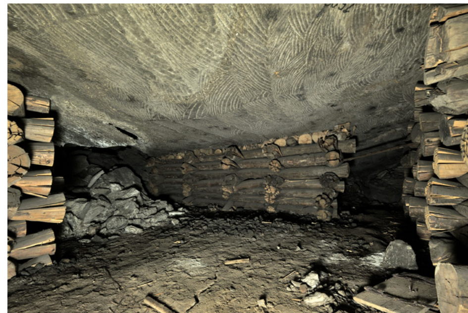
14. Komora Ksawer Górny. Zaciskanie kasztów podpierających rozległy strop wyrobiska (fot. K. Kozłowski)
