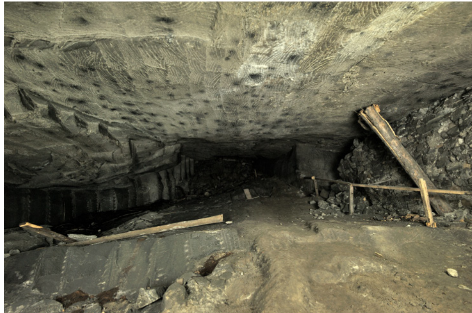
15. Komora Ksawer Górny. Zabezpieczenie wyrobiska podsadzką z urobku, wygradzoną murem solnym. Na stropie okopcenia w miejscach zawieszania kaganków (fot. K. Kozłowski)
