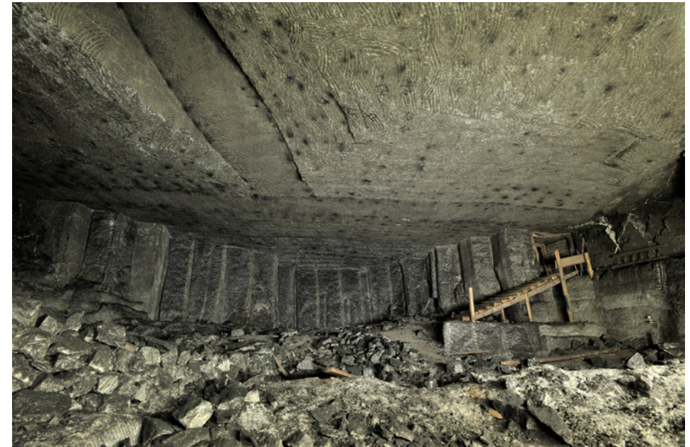
12. Komora Parnas. Negatywy oderwanych kłapci. Stropy chodników rozcinających bryłę soli zielonej typowej (fot. K. Kozłowski)
