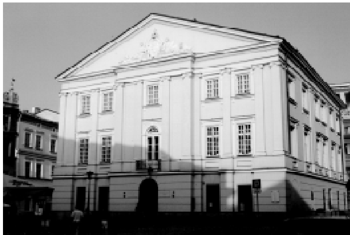
Budynek b. Trybunału Koronnego. Siedziba MBP od 1945 r.
