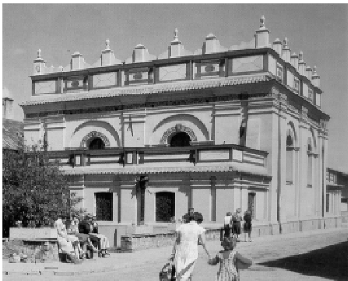
Siedziba Powiatowej i Miejskiej Biblioteki Publicznej w Zamościu
