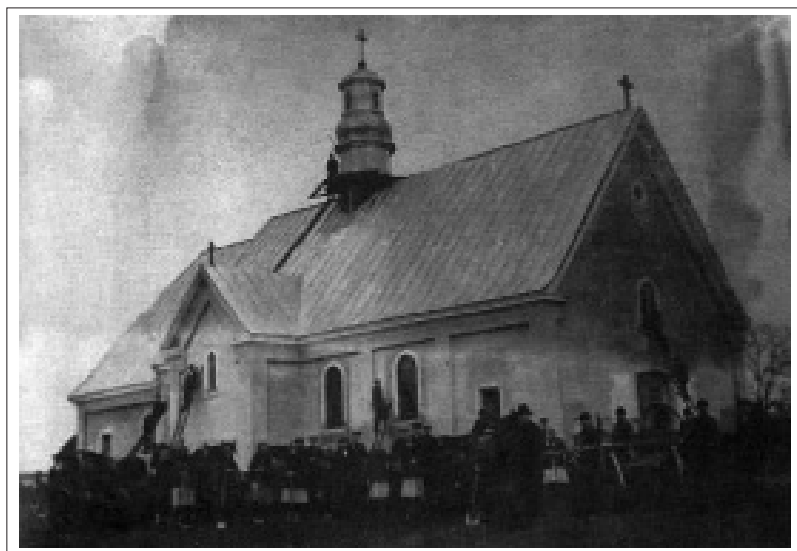
Kościół w Ostrówku w trakcie przebudowy, 1930 r., Archiwum parafii Ostrówek 31
