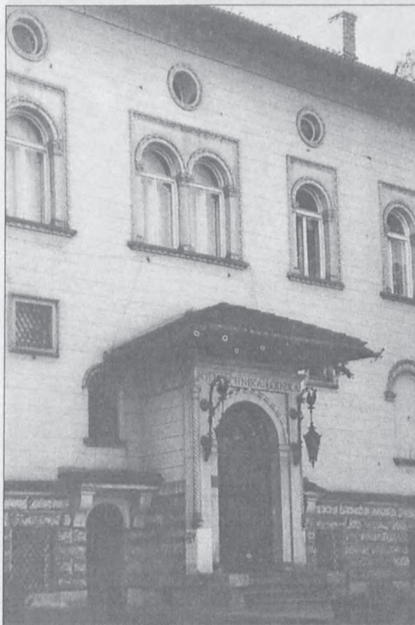
Fot. 10. Łódź, willa Józefa Richtera przy ul. ks. I. Skorupki 10/12, 1898, arch. Karl Seidl (?) (fot. autor)
