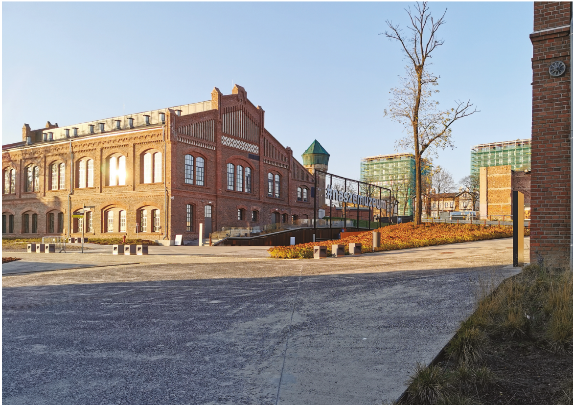
7. Budowa osiedla mieszkaniowego tuż za terenem Muzeum Śląskiego w Katowicach, listopad 2020
