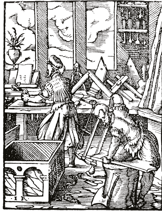
1. Pracownia stolarska z połowy XVI w. – ręczna obróbka drewna piłą ramową i strugiem typu niemieckiego z „nosem”, czyli uchwytem dla lewej ręki; widoczne także: ława stolarska – strugnica z imakami oraz narzędzia: długie strugi, tzw. spusty, węgielnice, cyrkiel, znacznik dwustronny, dłuta, świdy oraz pień i topór do obróbki ciesielskiej; materiał – tarcia nieobrzynana i deski; produkt finalny – skrzynia o konstrukcji ramowo-płycinowej z „fladrowymi filoniami”, tj. płycinami z drewna o bogatym rysunku stojów. Drzeworyt Josta Ammana, Der Schreiner , w: Stände und Handwerker , Frankfurt am Main 1568
