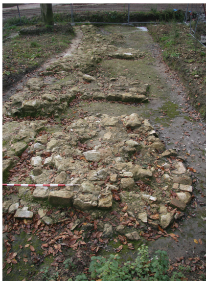
Fot. 1. Zator. Fragment muru obwodowego zamku z przyporami. Fot. K. Tunia
