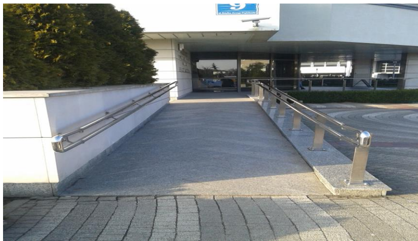
Rys. 1. Przykład pochylni dla osób z niepełnosprawnością ruchową. Ciąg komunikacyjny do budynku Biblioteki Głównej UPH Siedlce Źródło: Materiały własne.
