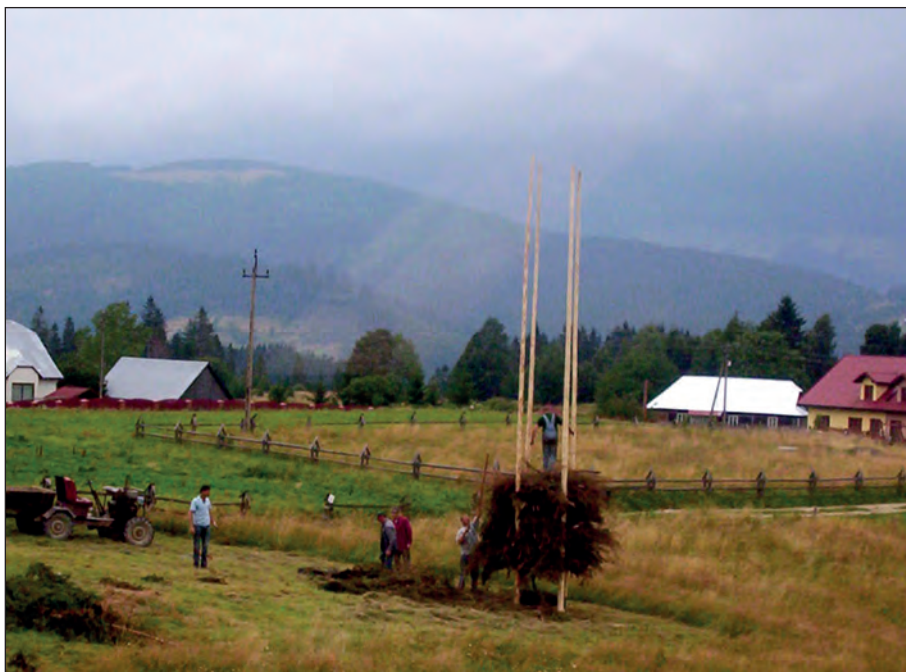
Fot. 1. Budowanie konstrukcji hudy – Butorówka, Beskid Żywiecki (fot. ze zbiorów autora)
