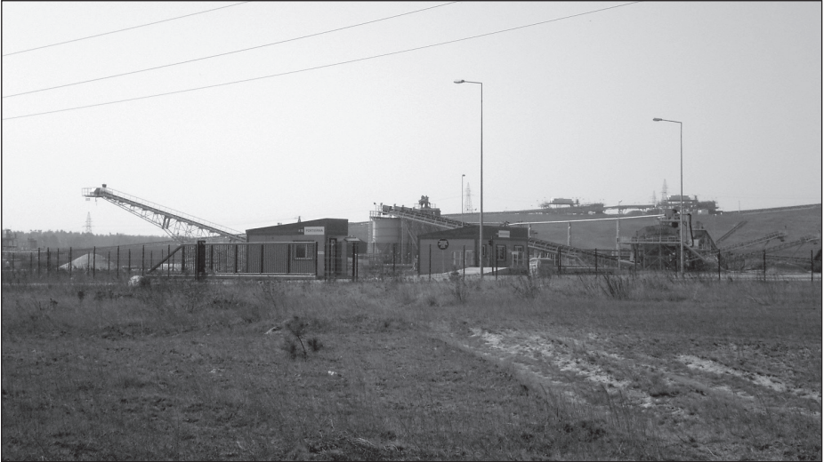
Fot. 3. Obiekty pomocnicze odkrywki Szczerców KWB Bełchatów (fot. K. Pędziwiatr) Photo 3. Auxiliary objects of the Szczerców outcrop in the Bełchatów Coal Mine (photo by K. Pędziwiatr)
