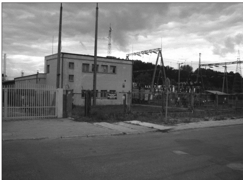
Fot. 2. Stacja elektroenergetyczna w Tomaszowie Mazowieckim, położona na obszarze zalewowym (fot. M. Borowska-Stefańska)
