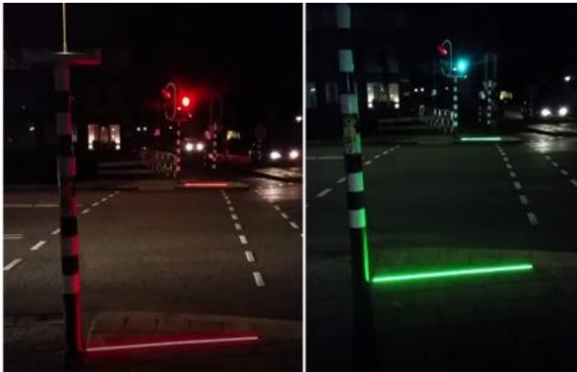
Rycina 6. Sygnalizacja naziemna dla smombów w Bodegraven
