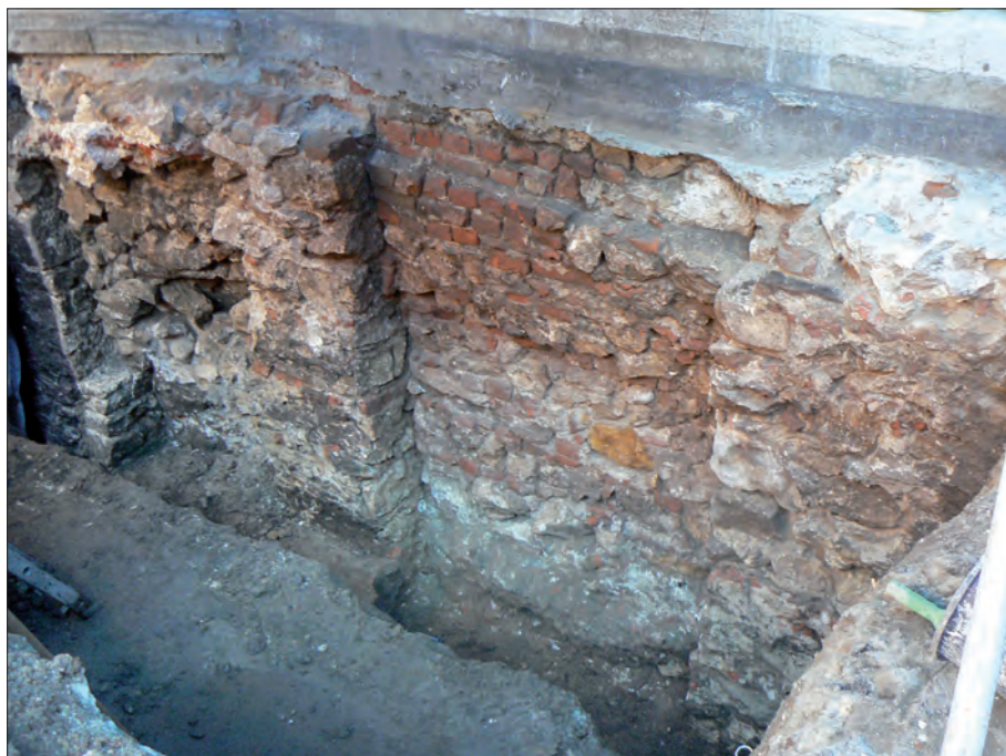
Il. VIII. Dziedziniec Collegium Maius. Północna partia fundamentu pod wschodnim odcinkiem krużganka. Od lewej: narożnik muru z ok. połowy XIV wieku oraz dwa fundamenty filarowe (koniec XV wieku), pomiędzy nimi wypełnienie z XIX wieku. Fot. M. Maciaszek
