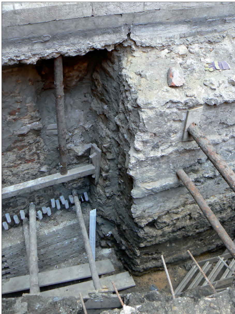
Il. IX. Dziedziniec Collegium Maius. Południowa partia fundamentu pod zachodnim odcinkiem krużganka. Po lewej wtórne uzupełnienie fundamentu (XIX wiek); po prawej narożnik fundamentu z końca wieku XV oraz dostawiony do niego od zewnątrz równoległy fundament szkarpy z pierwszej połowy XIX wieku – oba fundamenty rozdzielone pionową dylatacją. Fot. M. Maciaszek
