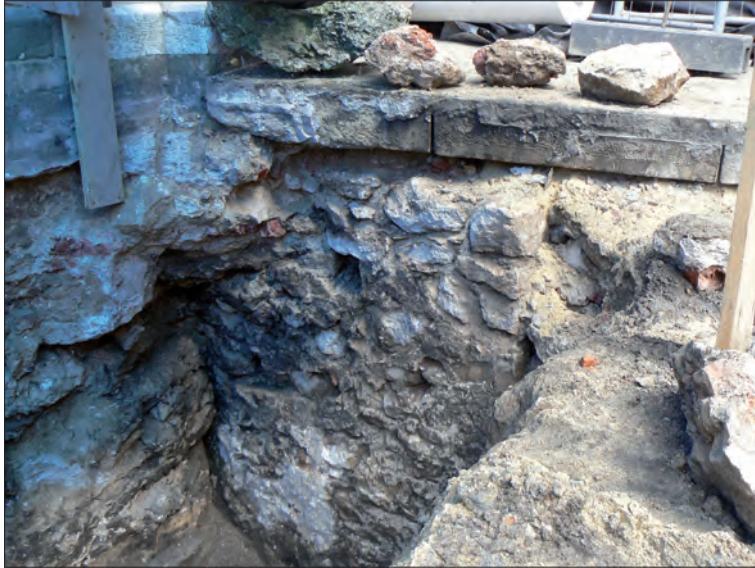
II. III. Dziedziniec Collegium Maius. Północno-wschodni narożnik fundamentu krużganka; po lewej fundament pod schody profesorskie (koniec wieku XV), po prawej mur z ok. połowy wieku XIV. Fot. M. Maciaszek
