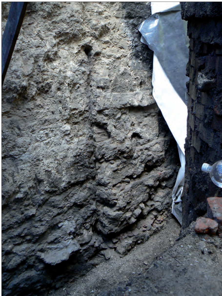
Il. XII. Podwórze przy ul. św. Anny 10, mur zachodni – fundament Kolegium Medycznego (XVII wiek) – styk partii północnej, z wyraźnym negatywem szalunku (po prawej) z partią południową (po lewej). Fot. M. Maciaszek
