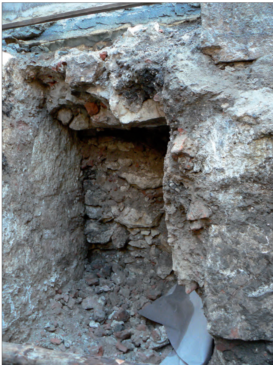
Il. XI. Podwórze przy ul. św. Anny 10, północny mur piwnicy z XV/XVI wieku, z zagruzowanym i częściowo zachowanym otworem wejścia z ulicy (obecnie pod murem granicznym w pierzei ulicy). Fot. M. Maciaszek
