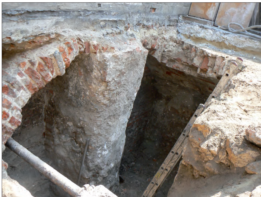
II. VI. Działanie Collegium Maius. Piwnica pod dziedzińcem, przy skrzydle północnym. Widok ogólny wnętrza piwnicy od strony południowo-zachodniej. Widoczne są: fundament filarowy pod słup krużganka (koniec XV wieku) oraz współczesne mu sklepienie piwnicy. Fot. M. Maciaszek
