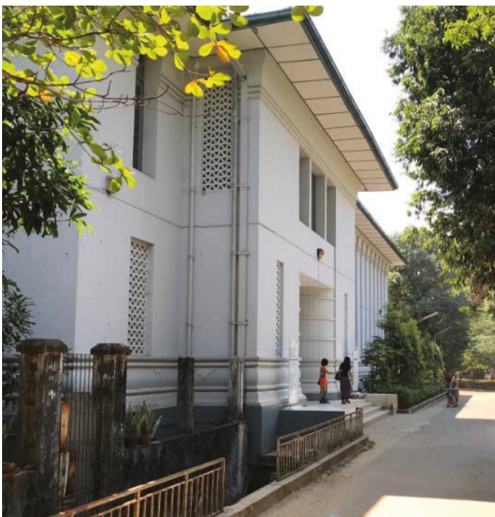
Zdj. 13. Biblioteka Uniwersytetu w Rangunie. Warto zwrócić uwagę na architekturę budynku, wysokie pomieszczenia i ażurowe okna, zapewniające wewnątrz przyjemne uczucie chłodu. Zdj. Renata Ciesielska-Kruczek.
