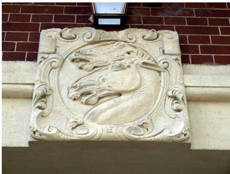
Fot. 1. Brynek, detal architektoniczny masztarni
