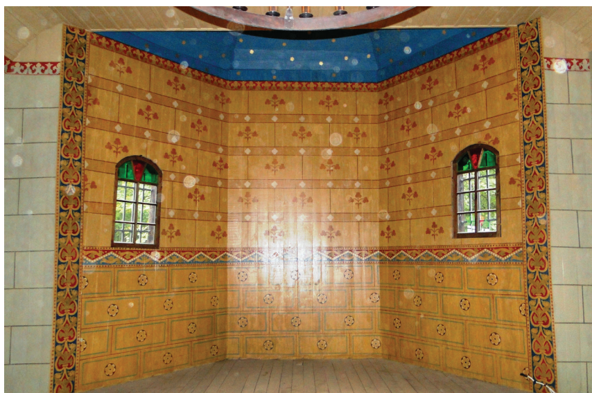
Fot. 30. Kościół cmentarny pw. św. Bartłomieja Apostoła w Smolnicy – szablonowa dekoracja malarska o formach architektonicznych w prezbiterium, 2. połowa XIX wieku
