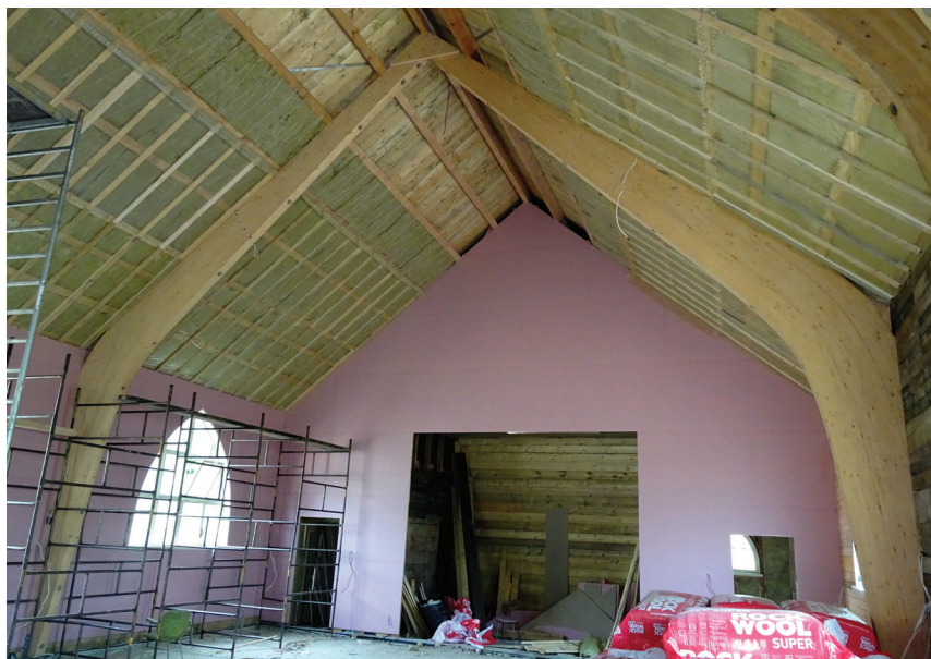
Fot. 10. Nawa kościoła z Bytomia-Bobrnka w trakcie układania płyt wykończeniowych na ścianach. Widoczna warstwa termoizolacyjna z wełny mineralnej osłoniętej folią paroizolacyjną na stropie jeszcze przed położeniem płyt gipsowo-kartonowych sufitu, 2017 rok
