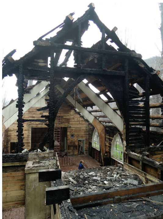
Fot. 4. Kościół z Bytomia-Bobrka w trakcie rozbiórki
