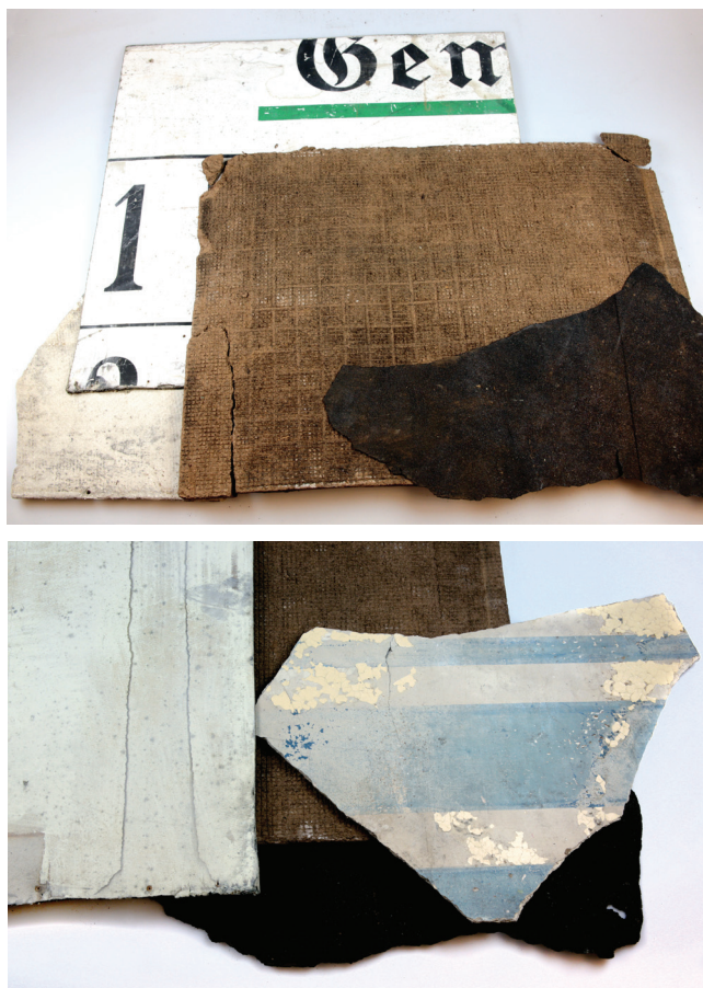
Fot. 8 a i b. Zachowane fragmenty materiałów wypełniających ściany szkieletowe kościoła z Bytomia-Bobrza – strony zewnętrzna (a) i wewnętrzna (b)
