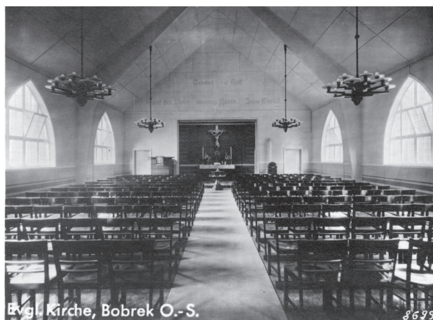
Fot. 2. Widok ogólny wnętrza kościoła z napisem na ścianie tęczowej. Fotografia z pocztówki z lat 40. XX wieku
