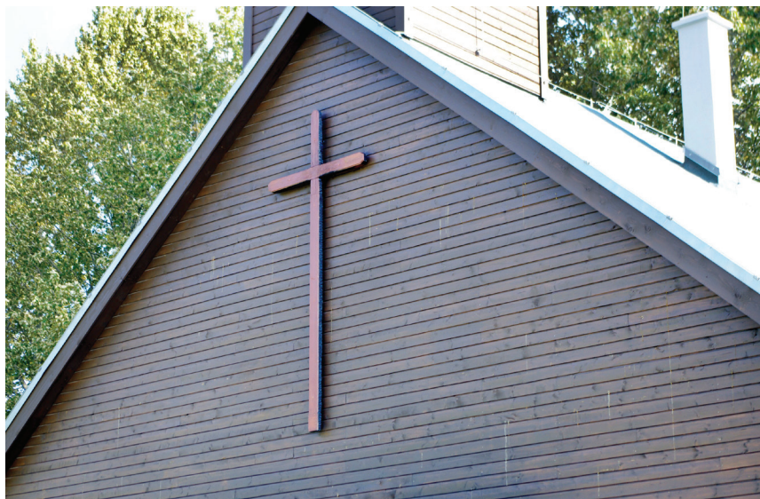
Fot.1. Krzyż znajdujący się na ścianie frontowej
