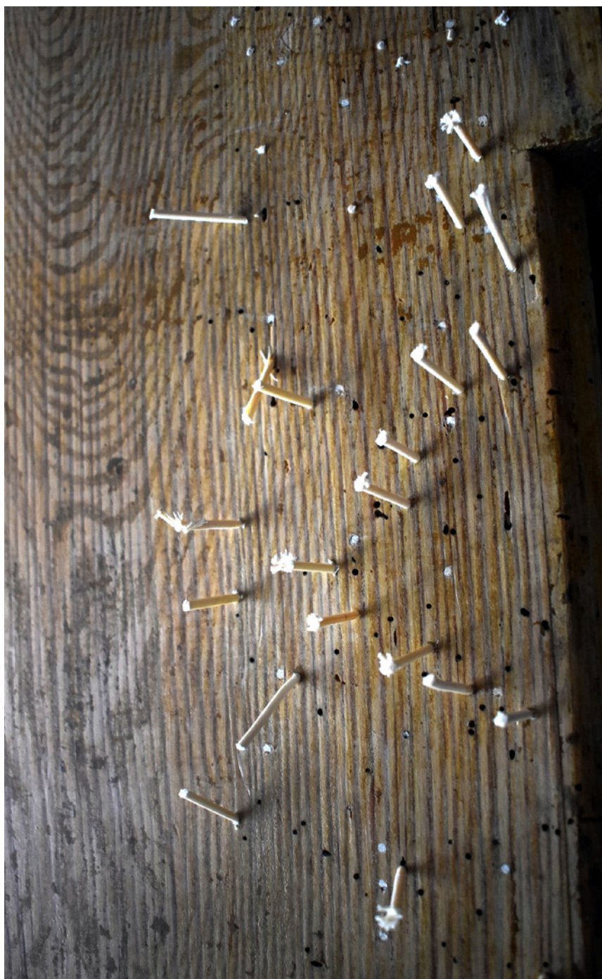
Fot. 7. Fragment jednej ze ścian bocznych komody podczas zabiegu flekowania drewnianymi kołkami
